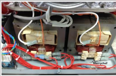
2000W e2s 变体：并排布置的两个高压变压器。
